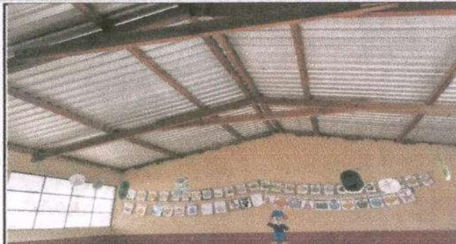
Foto1: Sustitucion de lámina por lámina troquelada aluzinc calibre 26 Escuela
